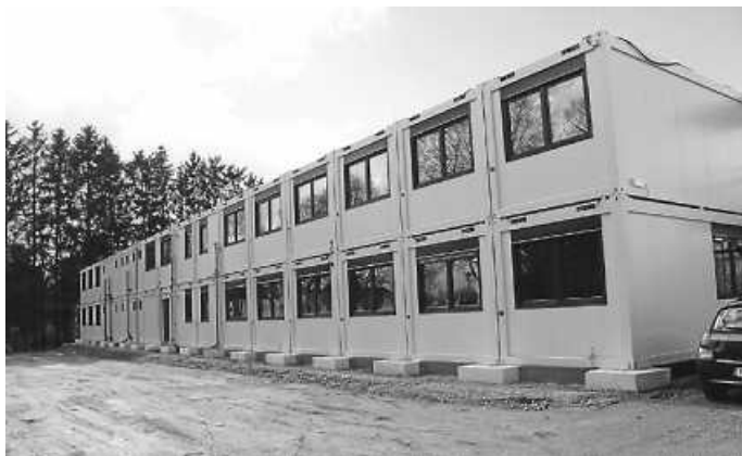
Die neue Gemeinschaftsunterkunft des Landkreises von außen, zur Straße hin wird noch ein Holzzaun als Sichtschutz gezogen.
