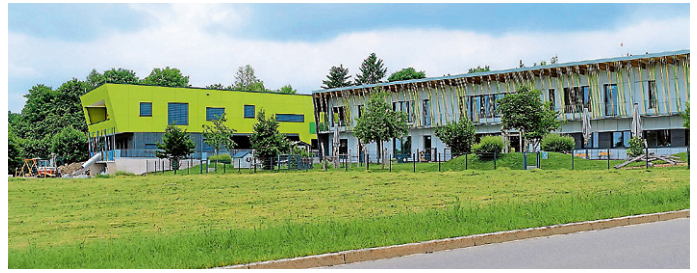
Die Kindertagesstätte Stadtkäfer - bestehend aus zwei Gebäuden - bildet eine harmonische Einheit in idyllischer Umgebung am Stadtrand von Bad Dürrhein
