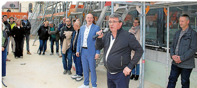
Bauleiter und Ortsvorsteher Franz Eisele (mit Mikrofon) informiert beim Richtfest über den Schulerweiterungsbau in Oberbaldingen, links von ihm Bürgermeister Jonathan Berggötz, rechts Jürgen Wenzler vom Stadtbauamt
