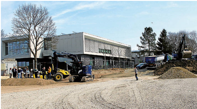
Der zweistöckige Neubau mit einer Grundfläche von 1800 Quadratmetern entsteht direkt neben dem Erweiterungsbau aus dem Jahr 2014.
