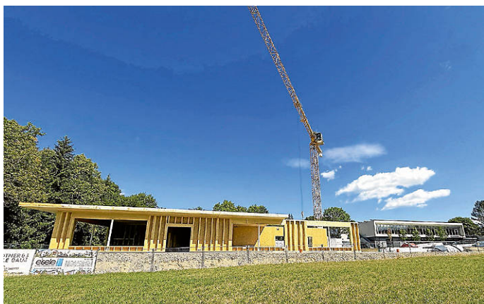
Der Neubau nimmt bereits deutlich Gestalt an. Im Hintergrund ist das bestehende Schulgebäude zu sehen.
