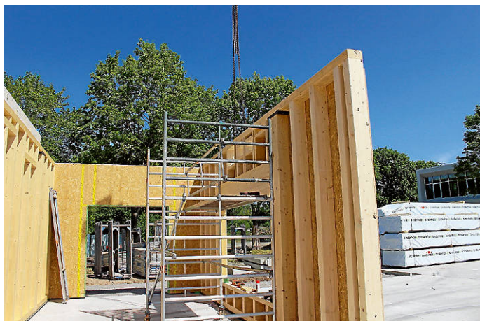
Millimeterarbeit: Die vorgefertigten Wandelemente für das zweigeschossige Unterrichtsgebäude werden passgenau montiert.
