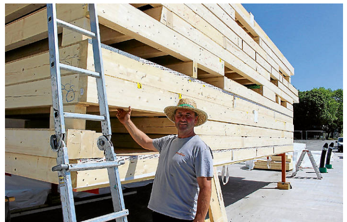
Zimmermann Martin Mahler zeigt einen der 32 Zentimeter hohen Vollholzbalken für die Decken. Der Transport zur Baustelle erfolgte per Sondergenehmigung bereits in den frühen Morgenstunden.
