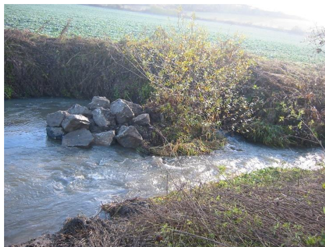
Neue Strukturelemente an der Kötach
